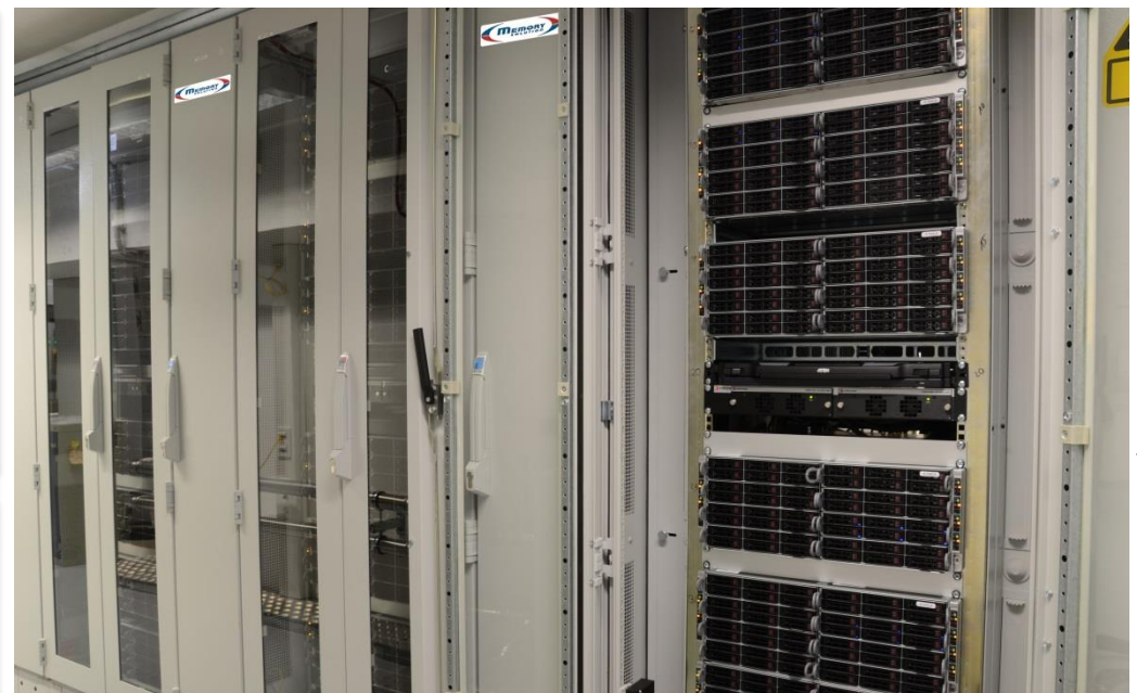
Rückseite mit 1GB- sowie 56GB/s-Netzwerk und DCLC-Leitungen...
